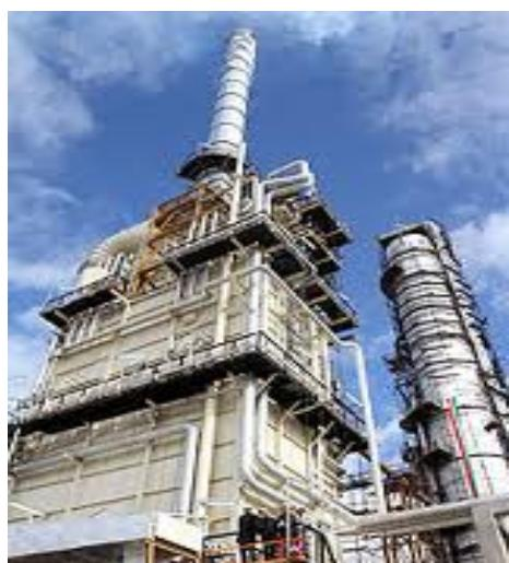
این پروژه در راستای اجرای سیاستهای دولت بمنظور افزایش کیفی و کمی تولید بنزین موتور اجرا می گردد. در این پروژه واحدهای گوگردزدایی از نفتا، تبدیل کاتالیستی مداوم و واحد اکسترکشن بنزن با ظرفیت ۲۰ هزار بشکه در روز احداث می گردد. با اجرای این طرح علاوه بر افزایش کیفی و کمی تولید بنزین موتور امکان تولید بنزین موتور با اکتان بالا (سوپر) بسهولت فراهم گشته و روزانه ۷۵۰ بشکه بنزن مورد نیاز پتروشیمی تبریز (که در حال حاضر از مبادی مرکز و جنوب کشور تأمین می گردد) تأمین خواهد گردید.
